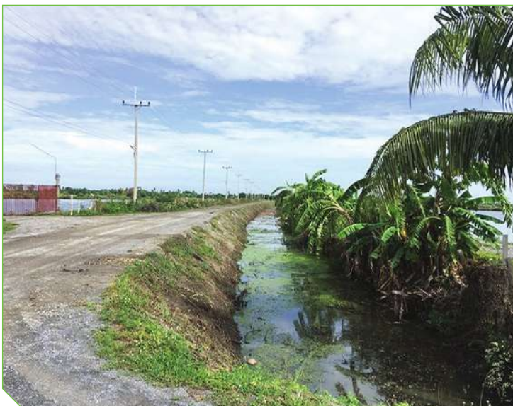
◀ หลังดำเนินการ หมู่ที่ ๔ ▶
