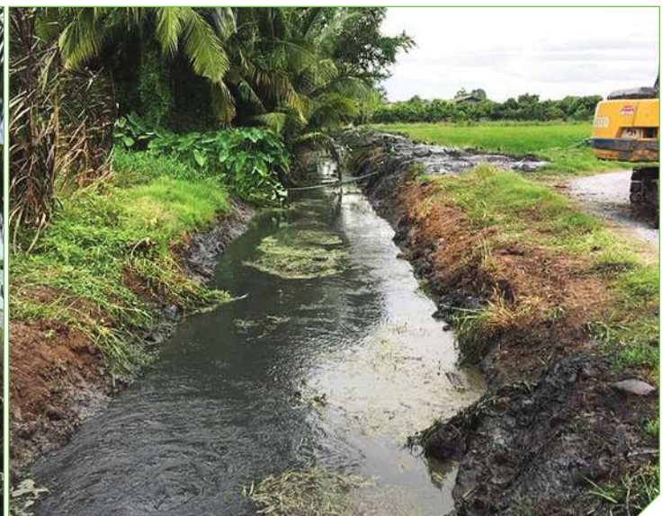
◀ หลังดำเนินการ หมู่ที่ ๑๒ ▶
